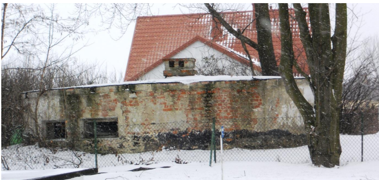
Fot. 3. Budowla okrągła- widok od strony budynku biurowego
