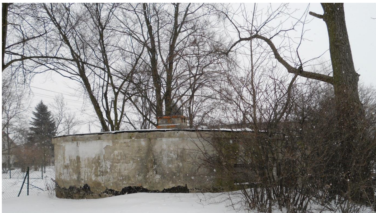
Fot. 2. Budowla okrągła- widok od strony budynku hydroforni
